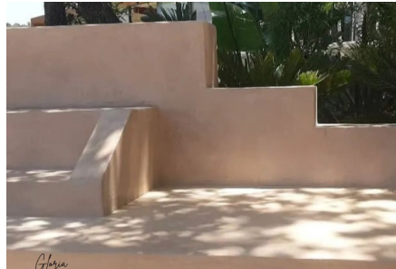
HORMIGÓN DE CAL
