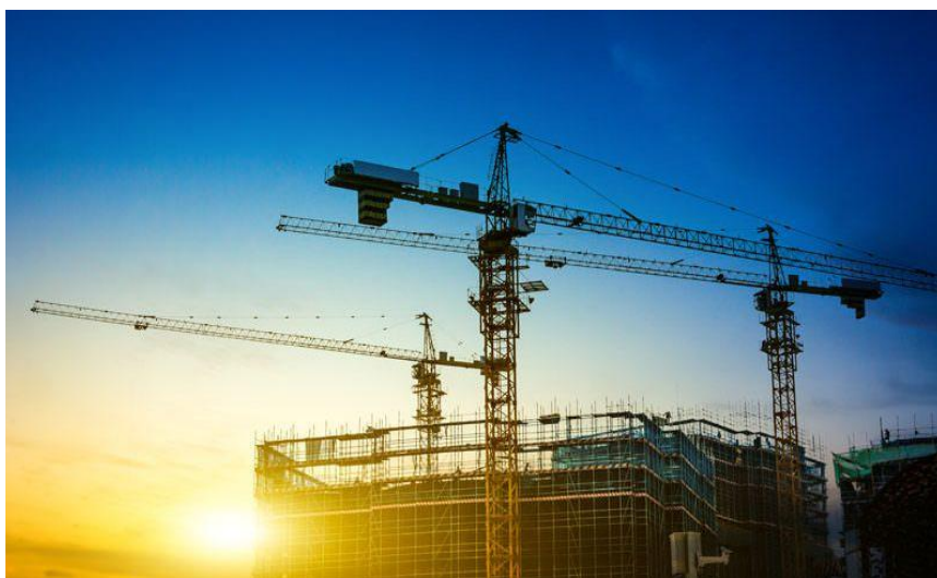
Figura 97. Imagen sector construcción. Fuente: elinmobiliariomesames.com.
