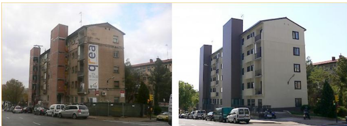
Figura 79. Mejora del aislamiento térmico en fachadas. Rehabilitación grupo de viviendas Alférez Rojas, Zaragoza, mediante aislamiento de fachada por el exterior con sistema SATE. Fuente: mbpbarriadasobsoletas.com .
