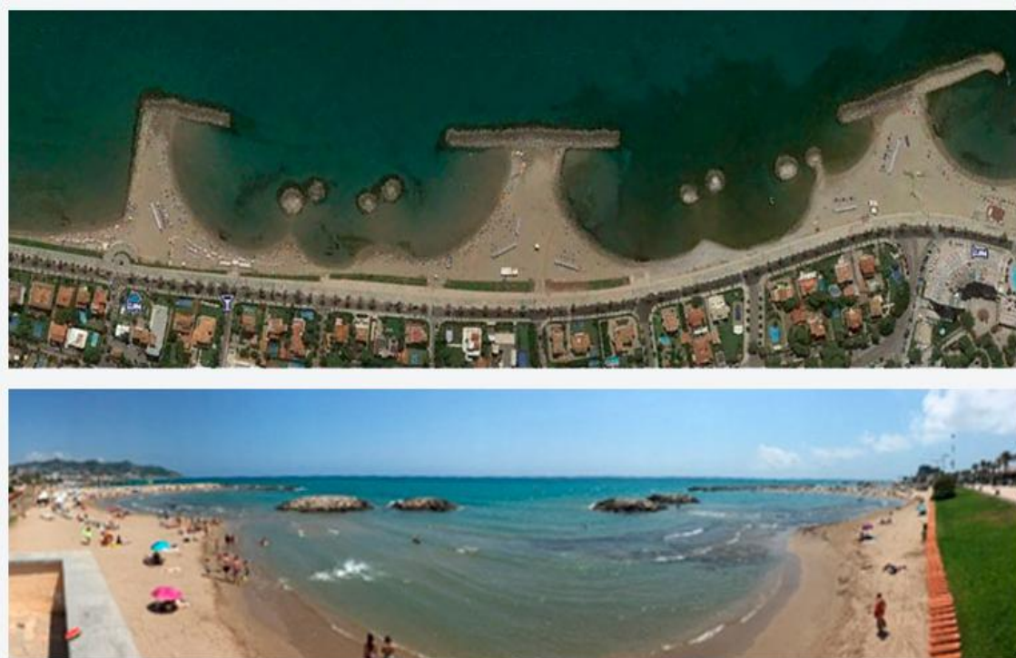
Figura 75. Playa estabilizada mediante sistema de diques y espigones. Sitges.
