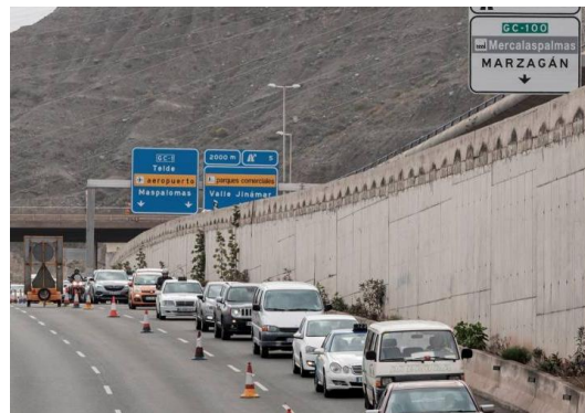
Figura 31. Congestión de tráfico por el derrumbe carretera GC-1. Isla de Gran Canaria, Fuente: El Correo Gallego
