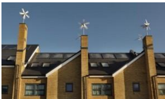
Figura 13. Energía Mini eólica instalada en edificaciones. Fuente: www.certificadosenergeticos.com
