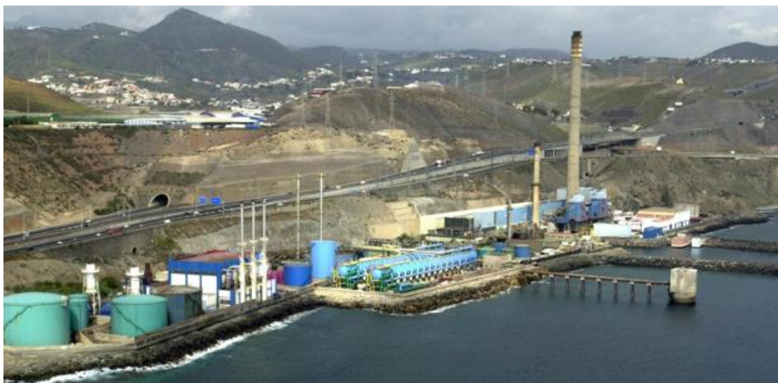
Figura 18. Vista aérea de las instalaciones de Emalsa en Piedra Santa. Gran Canaria. Fuente: Canarias7
