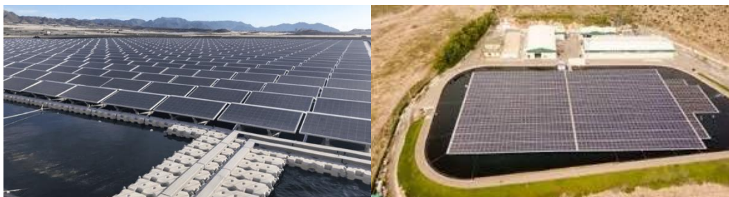
Figura68. Placas fotovoltaicas sobre balsa de agua en Mazarrón. Fuente: María Santos, Madrid (2020) “El éxito de la desalación de agua requiere más energías renovables”. Disponible: https://www.elagoradiario.com/aqua/el-exito-de-la-desalacion-de-aqua-requiere-mas-energias-renovables/
