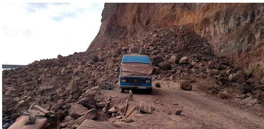
Figura 85. Derrumbe de un acantilado en Vallehermoso (La Gomera) en noviembre de 2020, afectando a varios vehículos y caravanas. Fuente: Diario de Avisos
